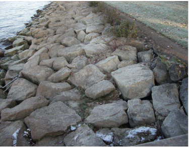
Foto: Böschung Bestand
