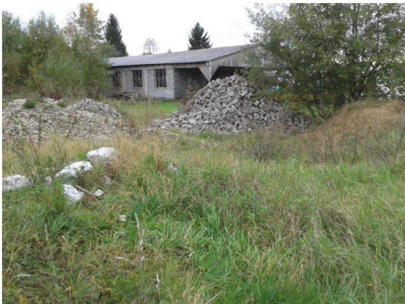
Gewerbliche Lagerfläche, nordwestlicher Bereich: der geplante Damm wendet sich vor dem Schuppen in der Bildmitte nach Norden (im Bild rechts)
