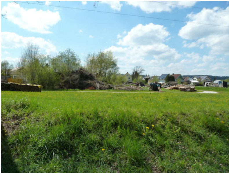
Gewerbliche Lagerfläche, nördlicher Bereich: der geplante Damm wendet sich beim Gehölzschnitthaufen in der Bildmitte nach Westen zur Siedlung
