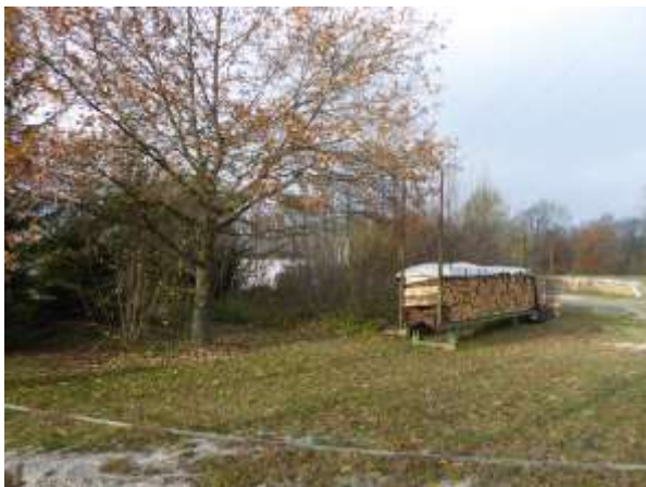
Foto 9: Der Damm führt hier durch ein Gebüsch, in dem zahlreiche alte Dachplatten-Stapel liegen.
