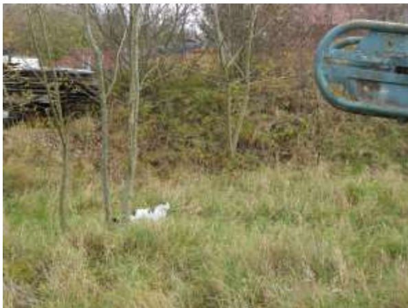
Foto 8: An diesem großen Erdhaufen knickt der Damm wieder nach Süden ab.
