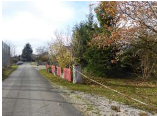
Foto 10: Kurz vor dem roten Zaun-Elementen quert der Damm hier den Flößerweg.
