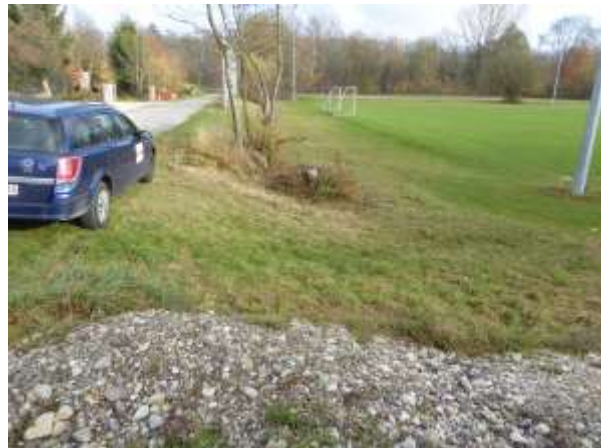
Foto 11: Damm-Verlauf entlang der nördlichen Sportplatz-Grenze, im Vordergrund der Kieshaufen, an dem er das letzte Mal nach Süden abknickt.
