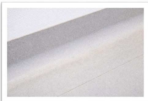
Boden-Abflüsse sind zu verschließen. Der Boden muss leicht zu reinigen sein. Ein fugenloser Wand-Boden-Übergang ist vorzusehen. Im gesamten Labor muss eine Abdichtung von feststehendem Mobiliar zum Fußboden vorhanden sein.
