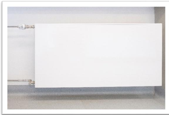
*Abbildung 5: Heizkörper mit geschlossener Frontseite*
