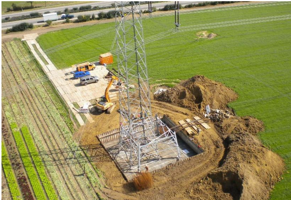
Abbildung 5: Baustelleneinrichtung mit Fundamentgrube
