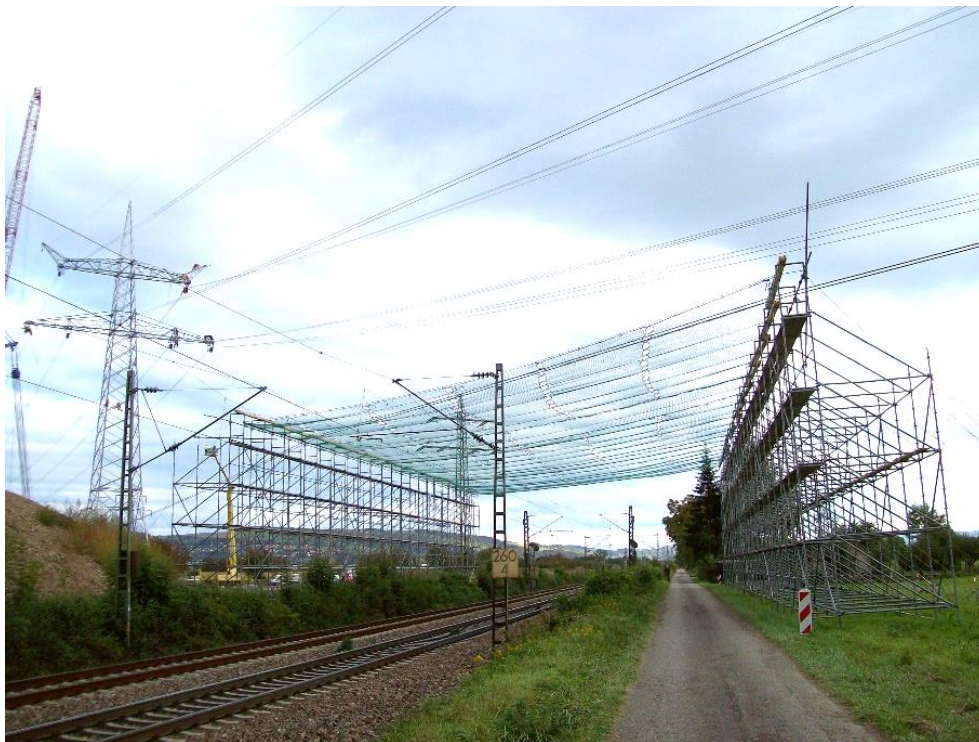
Abbildung 6: Schutzgerüst mit Netz an einer Bahntrasse
