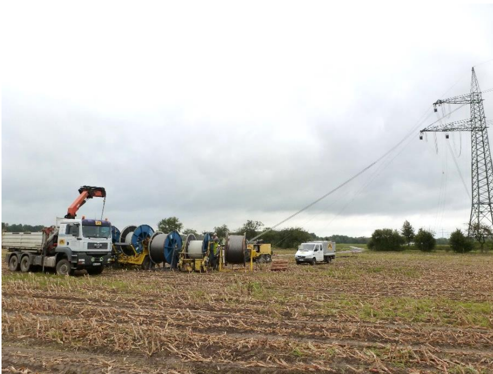
Abbildung 8: Seilzugarbeiten
