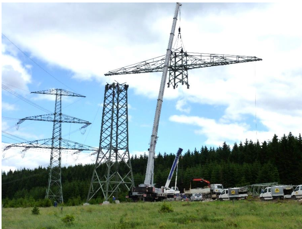
Abbildung 7: Maststocken mit Mobilkran
